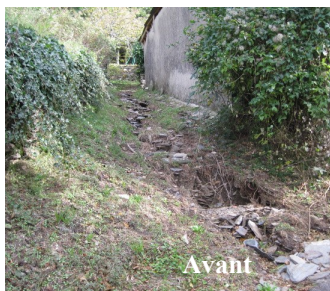
Travaux Rue de la Source à Escandelle
